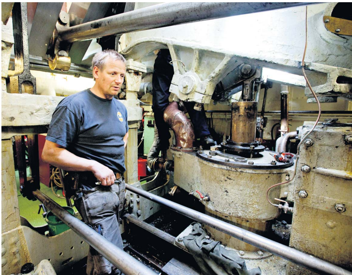
ENDELIG FERDIG: Mekaniker Kjetil Hansen og kollegene fra Ringsaker industriservice har tilbrakt mesteparten av pinsen om bord i maskinrommet til Skibladner. Nå er skipet reparert og klart for nye oppdrag. FOTO: CHRISTIAN E. BERGHEIM
